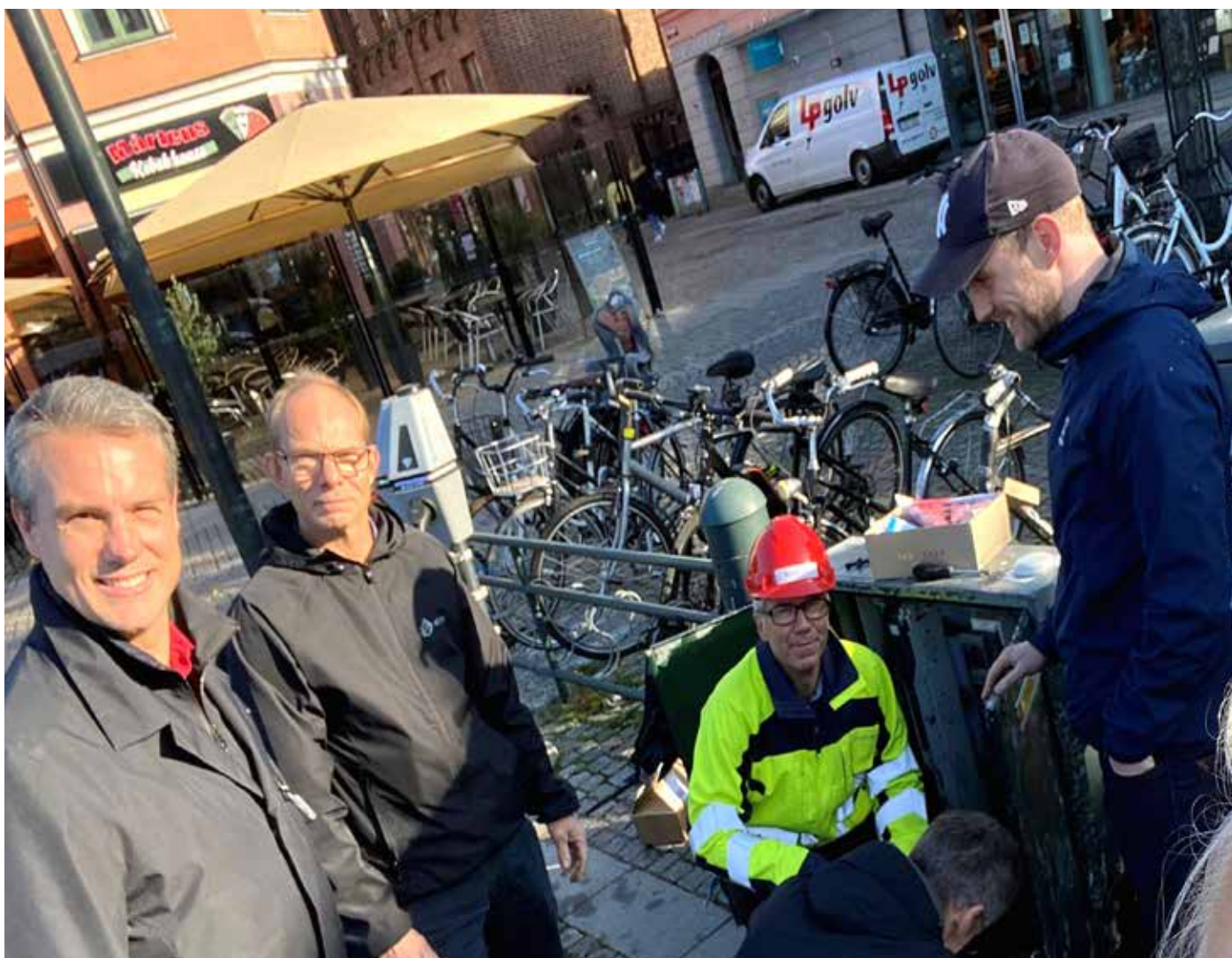
Johan Lindén, Mobile Heights och Magnus Edelberg divM övervakar installation av sensorer i Krafringens laddstolpar. Håkan Skarrie, Krafringen och Euan Muir, divM är i full färd med installationen.
