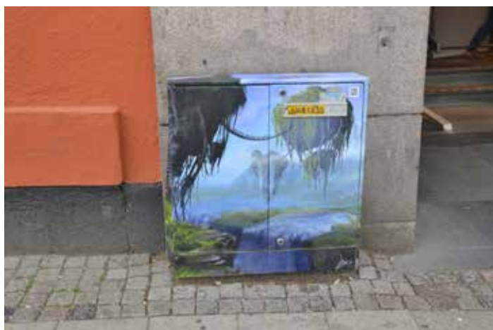
Kabelskåp i Lund.
