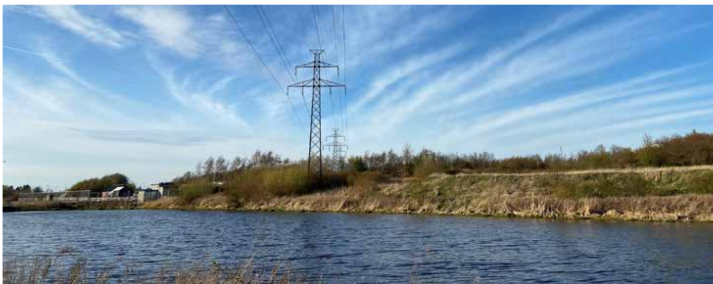
Kraftledning i södra delen av Lund.
